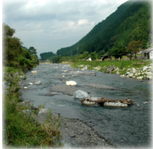
曙橋下流 (組合事務所前)
